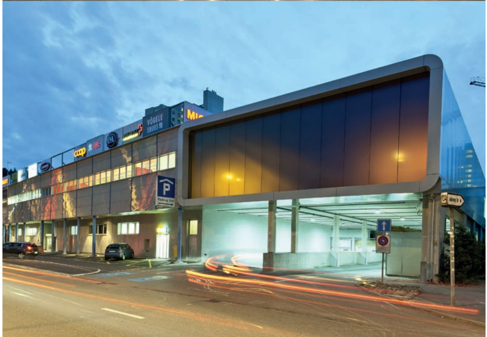
Zentrum Regensdorf, Erweiterung und Facelifting, 2013/2014
