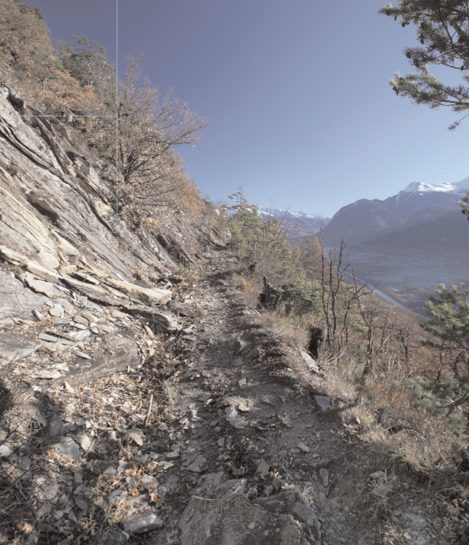
Wasserkanal (Suone/Bisse) bei Lens vor der Wiederherstellung
