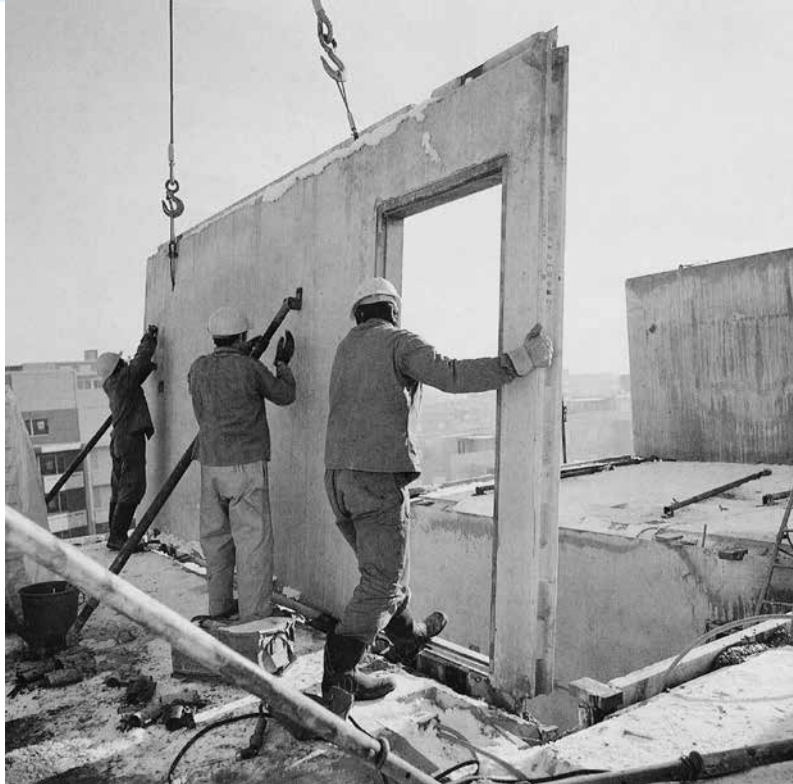
Göhnerbau mit Fertigelementen in Volketswil, 1966
